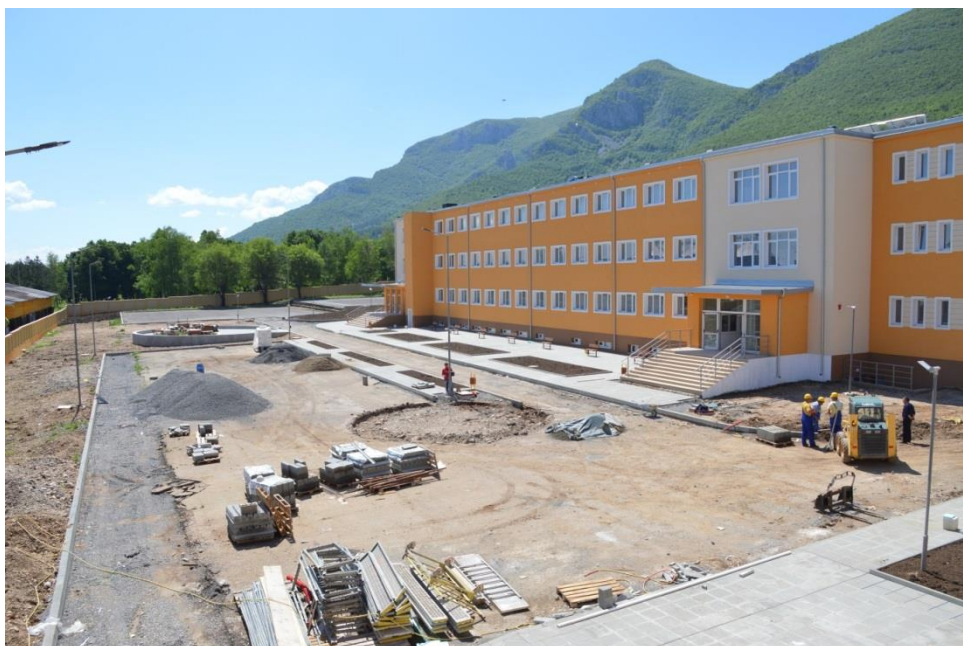
Изглед от строителната площадка
